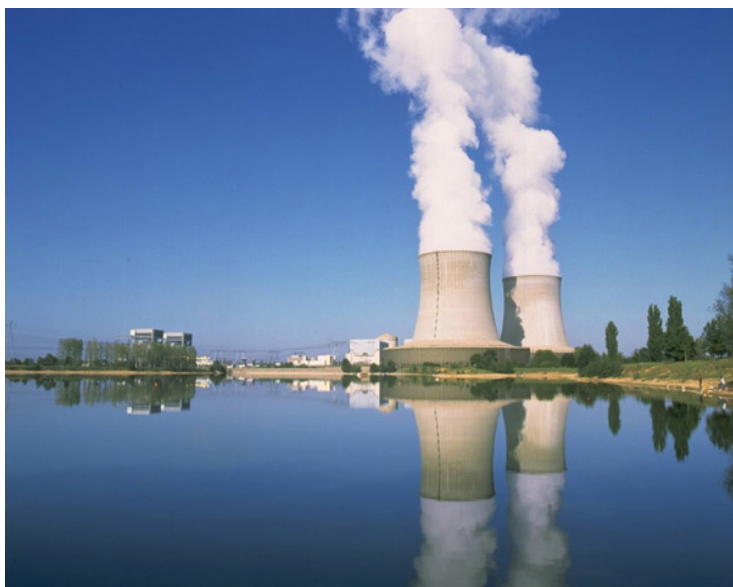
La centrale de Saint-Laurent-des-Eaux
